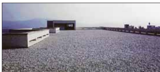
Фабрика на ОПЕЛ, Сарагоса, Испания 80 000 m 2
